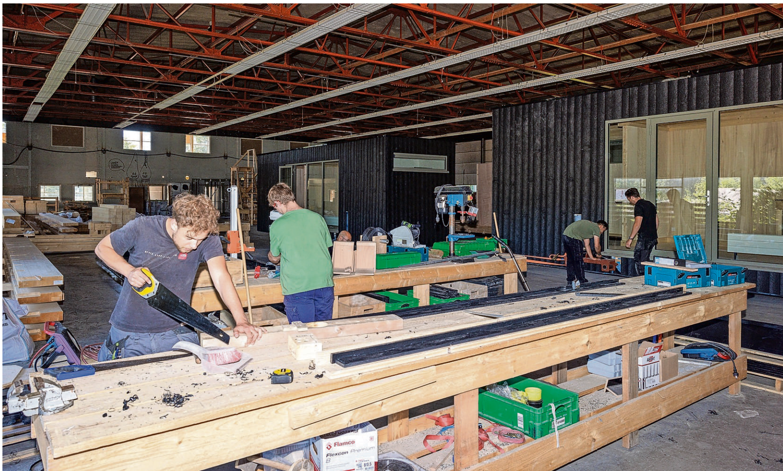
In de oude Philipshallen wordt hard gewerkt aan modulaire woningen van hergebruikte materialen.
